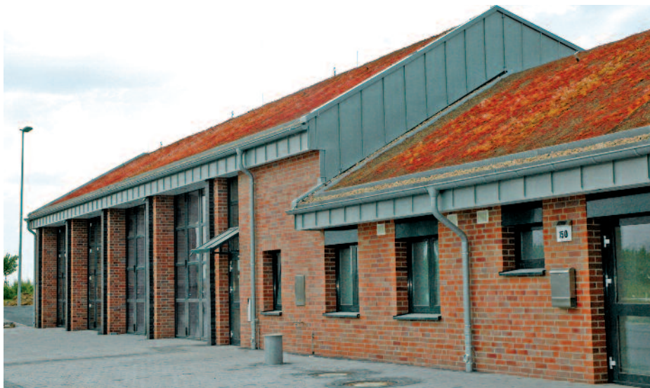
Das neue Feuerwehrgerätehaus in Königswinter-Bockeroth ist im Herbst 2010 offiziell eingeweiht worden. Finanziert wurde es im Rahmen einer öffentlich-privaten Partnerschaft.
