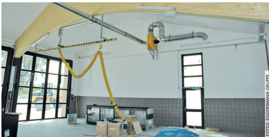
In der großzügigen Fahrzeughalle haben vier Einsatzfahrzeuge Platz, mit der Möglichkeit auf einen weiteren Stellplatz.
